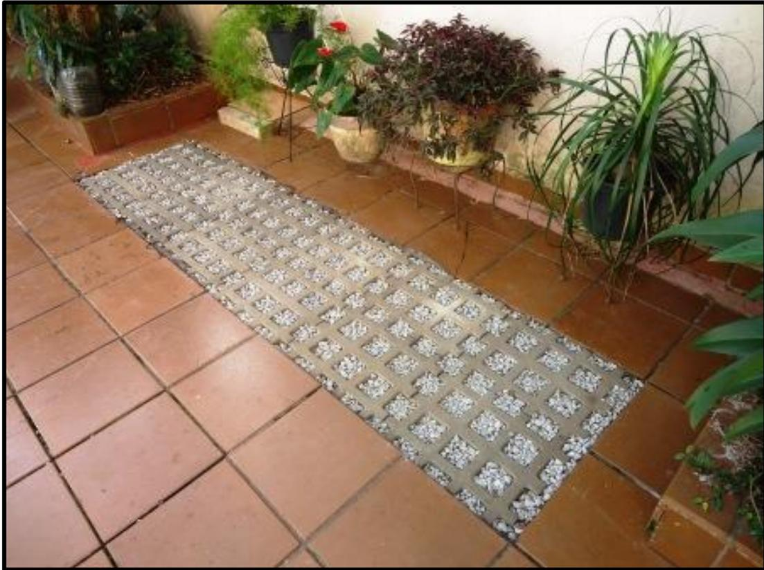
*Foto de um dispositivo doméstico de acumulação/infiltração já instalado em plena operação*
