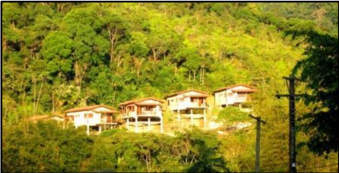
*Exemplo de concepção (laje sobre pilotis) adequada a terrenos de média e alta declividade*
