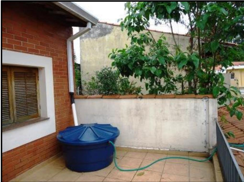
*Uma outra instalação para acumulação e uso de águas de chuva incidentes sobre telhados*
